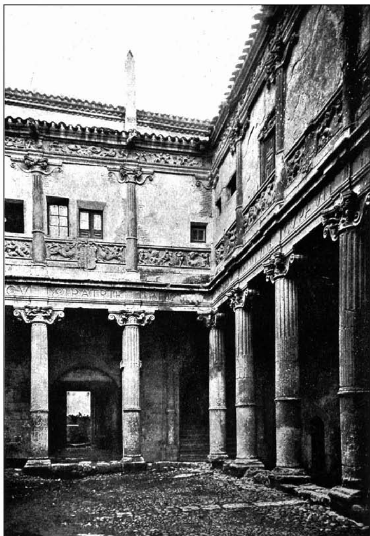
239. CASA DE MIRANDA въ Бургосѣ. Дворъ (patio), окруженный колоннадами съ типичной формы капителями.
